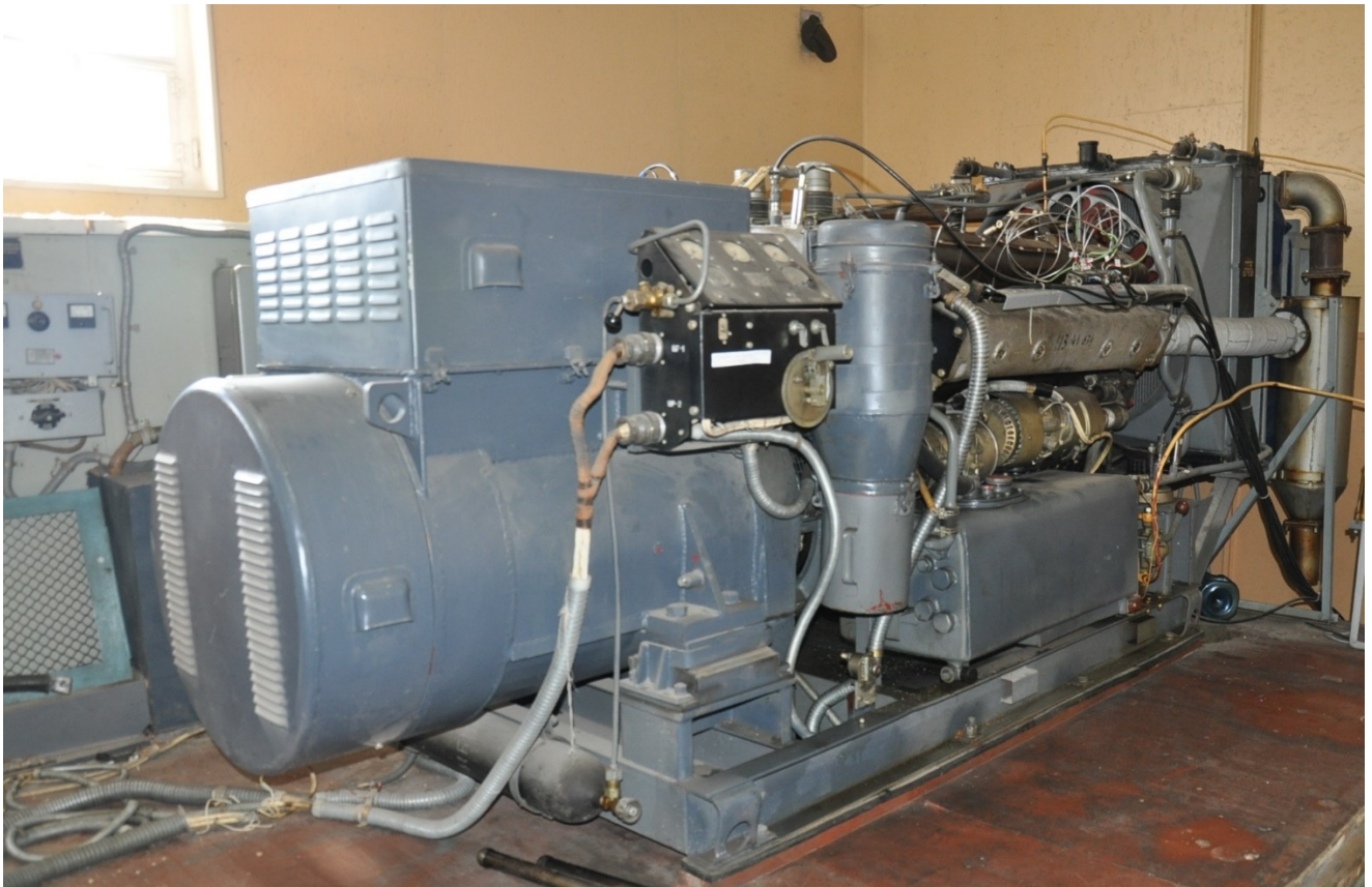
Стенд для випробування дизель-генераторної силової установки
